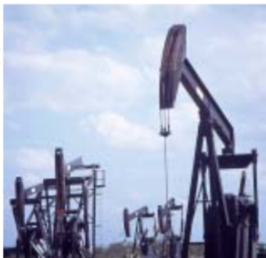
La unidad de Ingeniería e Infraestructura, conformada por un equipo multidisciplinario de ingenieros encargados de controlar, evaluar y proteger las instalaciones de superficie petrolera
